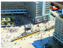
BVG baut für bessere Bahn
